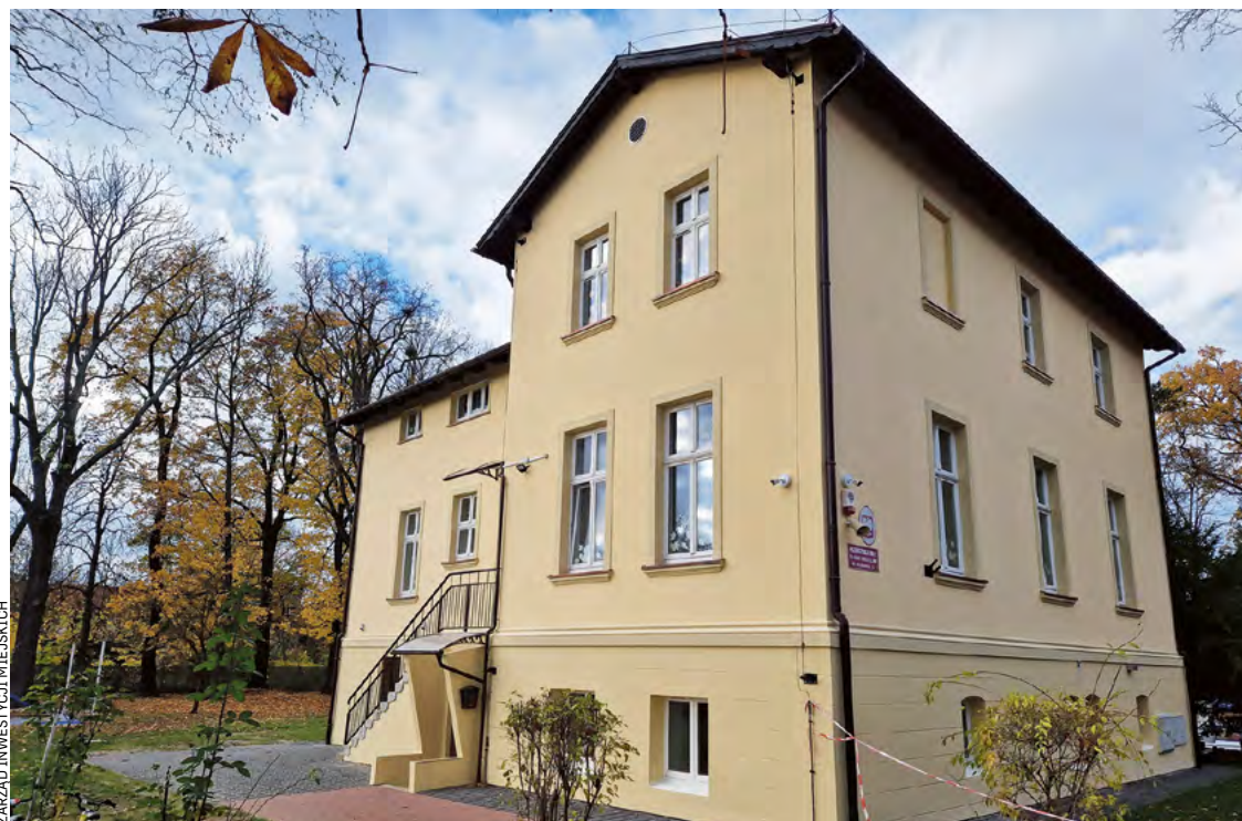
Tak prezentuje się nowa elewacja zabytkowego budynku przy ul. Sławka 5, w którym uczą się przedszkolaki
